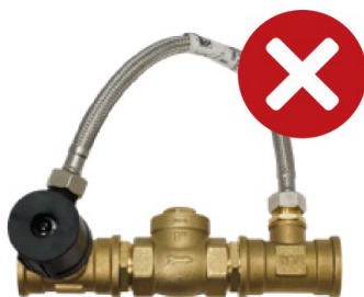
Utrudnione odpowietrzanie wężyka.
